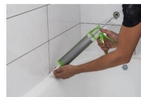
Рис. 2. Обработка санузлов герметиком
